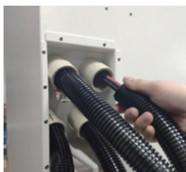
コルゲートチューブの取付け (本体筐体外側)
